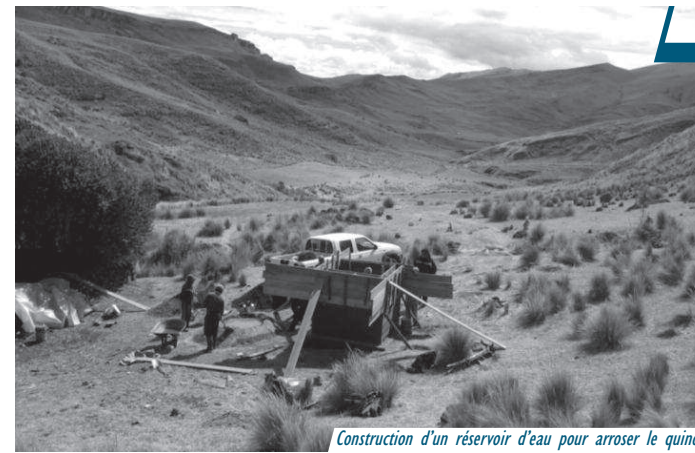
Construction d'un réservoir d'eau pour arroser le quinoa
